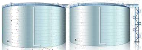
Tanques de almacenamiento de la terminal
